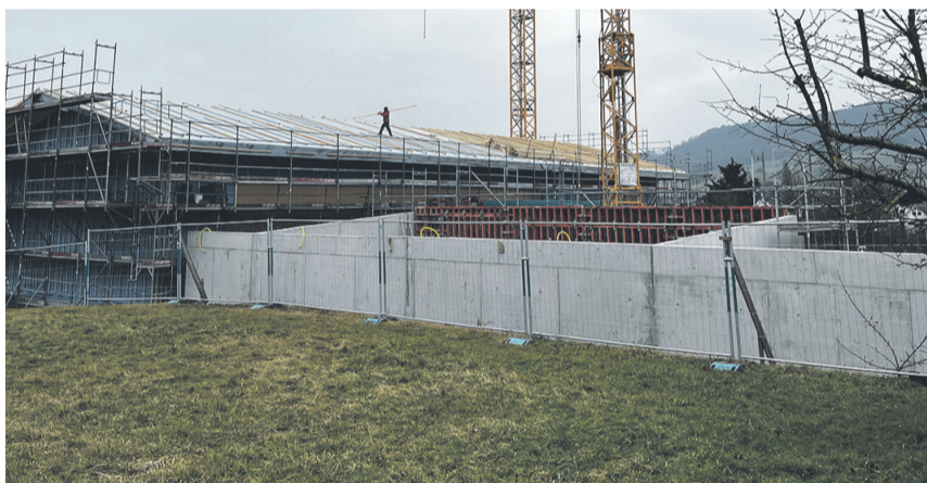
Die Boxen für das Schüttgut stehen bereits.
