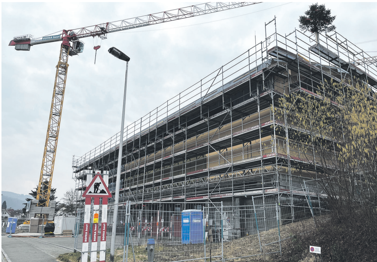
Der Rohbau steht, jetzt läuft der Innenausbau für den neuen Werkhof in Magden.
